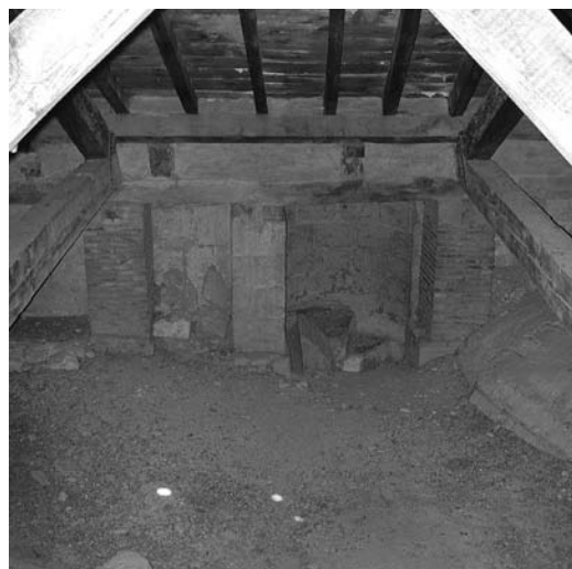
Figura 3 Pilastras de piedra y ladrillo para apoyo de la estructura de madera (foto de los autores 2003)
