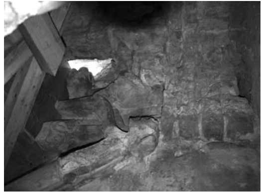
Figura 13 Vista desde el bajo cubierta del arranque de la ornamentación de la fachada oeste (foto de los autores 2008)
