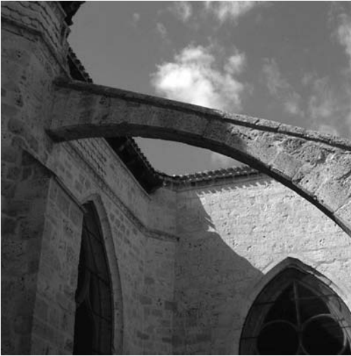
Figura 11 Encuentro entre la nave central con la del crucero, donde se ve el cambio de alero de canes a cornisa de piedra (foto de los autores 2010)
