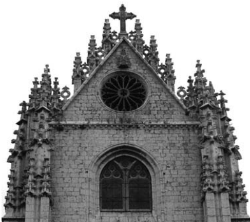
Figura 12 Remate de la fachada este, visto desde el frente, con hastial de gran pendiente (foto de los autores 2007)
