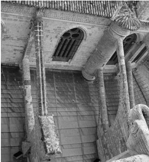
Figura 6 Vista de la cubierta de la girola baja y la nave central desde la torre (foto de los autores 2003)
