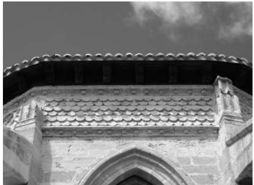
Figura 7 Imagen del peto de la zona del ábside (foto de los autores 2003)
